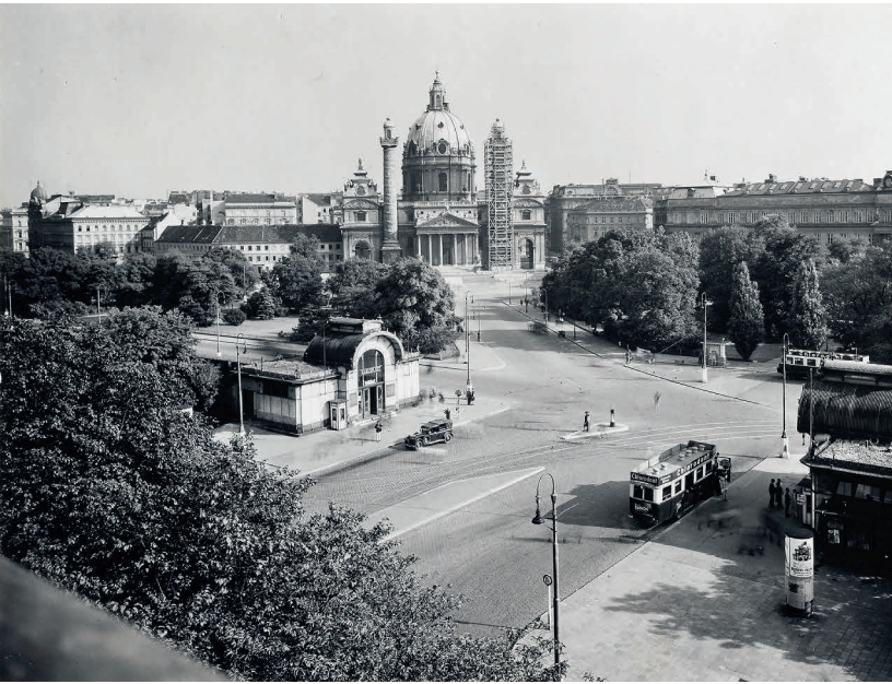
Abb. 6: Ansicht der Karlskirche, rechte Säule mit Gerüst, Aufnahme 1941
