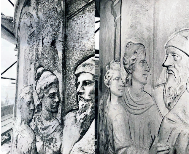
Abb. 8a: Reliefdetail, Vor- und Endzustand, Aufnahme 1975/76
